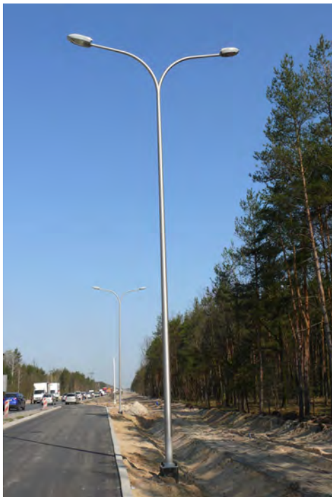
„Nowe” oprawy wysokoprężne
