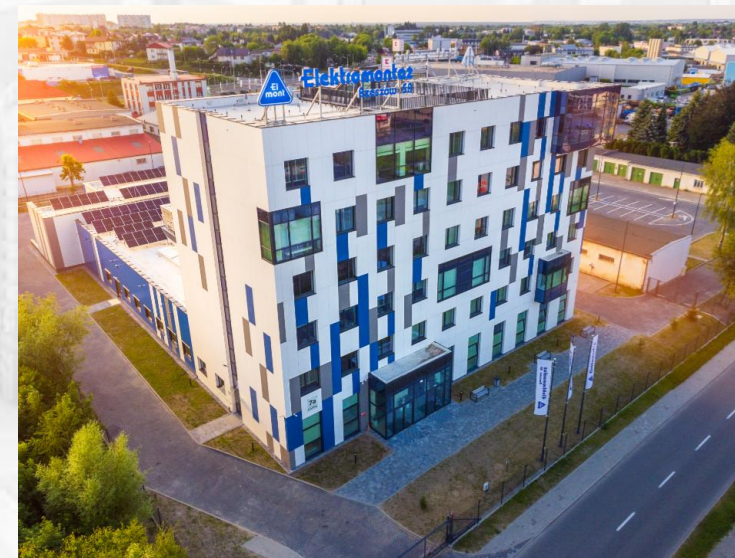
Nowa siedziba Elektromontażu Rzeszów S.A. zlokalizowana przy ul. Baczyńskiego 7A, wraz z Produkcją rozdzielnic SN oraz NN od marca 2022 roku
